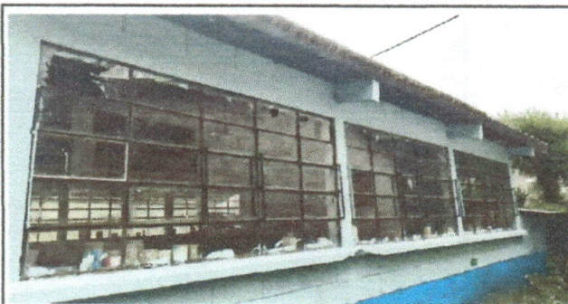
Foto 4: REPARACION DE VIDRIOS Y BALCON PARA EL MODULO DEL AULA DE PREPRIMARIA.
