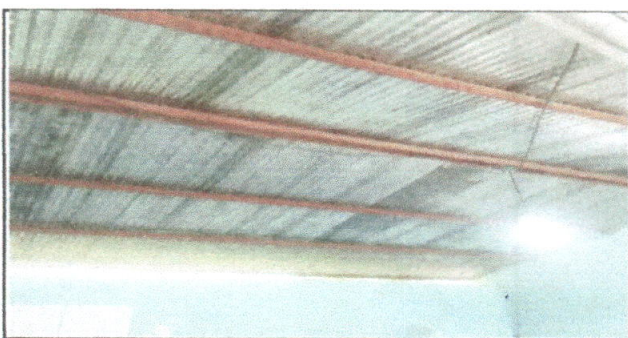
Foto 6: Cambio de lámina normal a troquelada de dos aulas
